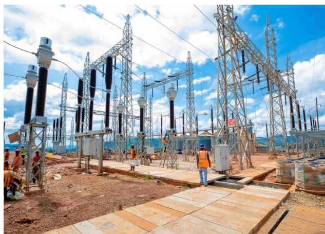
Des réseaux électriques en pleine expansion
