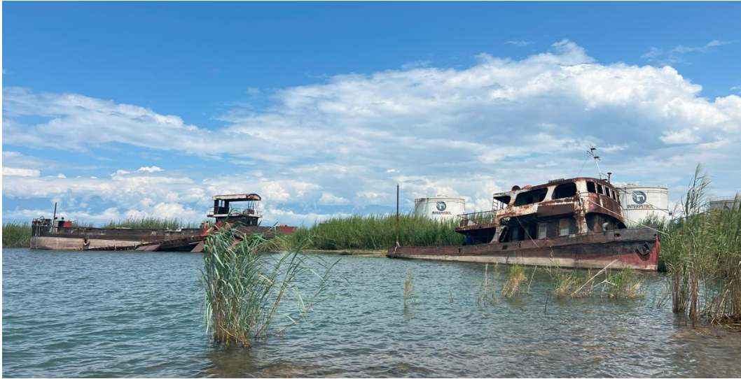
Figure 19 Terminal pétrolier inondé et la présence d'épaves
