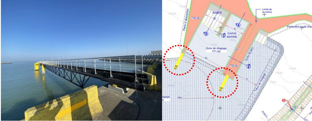
Figure 53 d'un duc-d'Albe équipé d'une passerelle d'accès d'un duc-d'Albe équipé d'une passerelle d'accès sur le dessin de Réhabilitation
