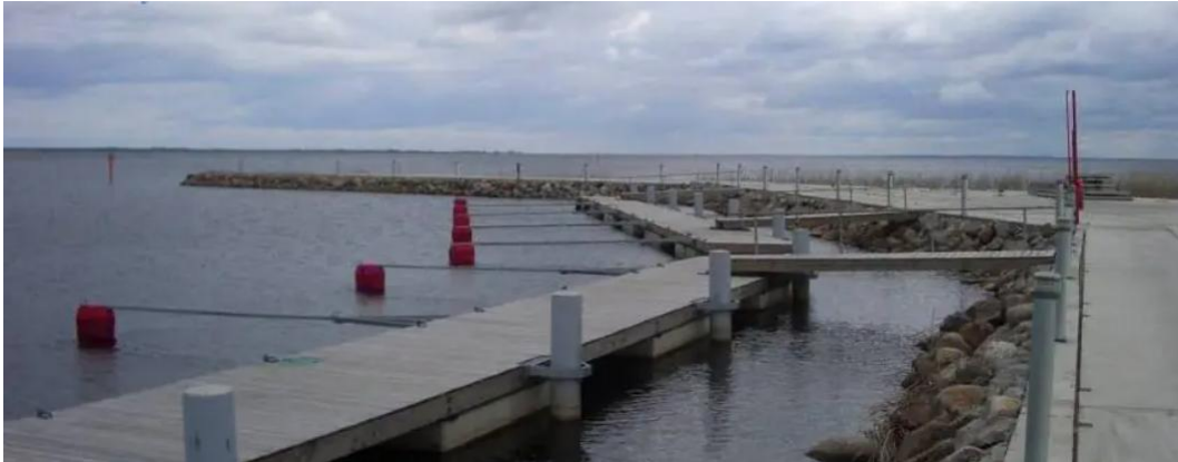
Figure 65 installations pour l'amarrage des navires de plaisance 50
