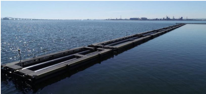
Figure 74 Exemple d'une digue flottante contre les vagues 58
