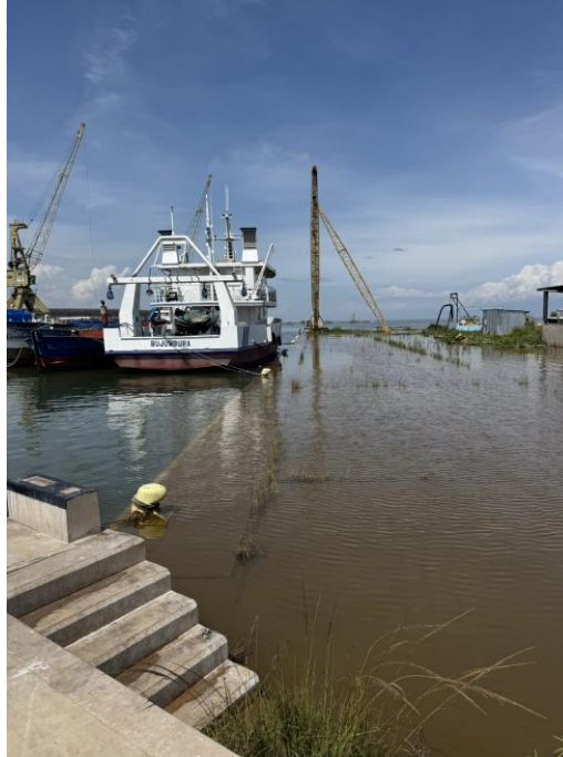
Figure 10: Quai portuaire inondé à cause de la montée des eaux du lac Tanganyika.
