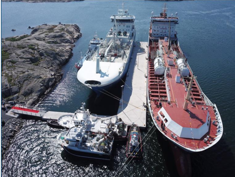
Figure 55 Exemple d'une jetée flottante en béton (Suède) 44
