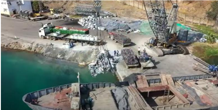
Figure 38: Opérations au port de Mpulungu. La capacité pour traiter des conteneurs est limitée
