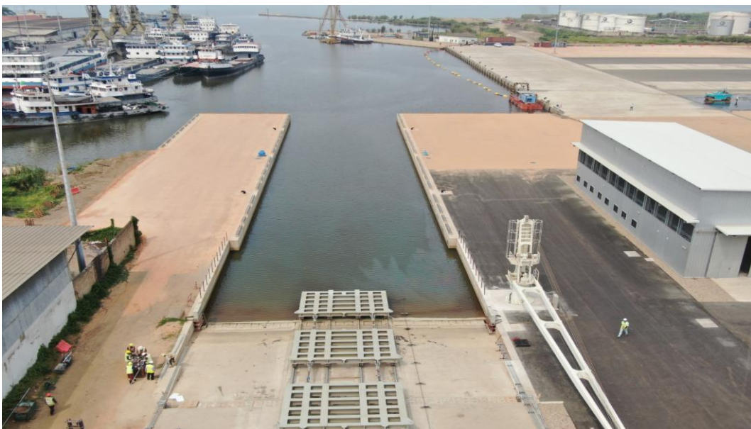
Figure 83: Chantier Naval de Bujumbura et le terminal à conteneurs
