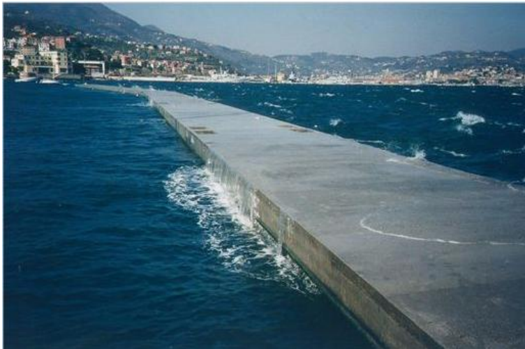
Figure 66 Exemple d'une digue flottante type « floating box-breakwater » 51
